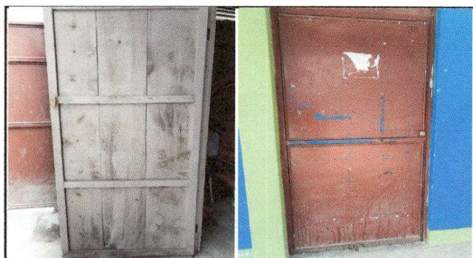
Foto 3: Sustrucción de puertas
