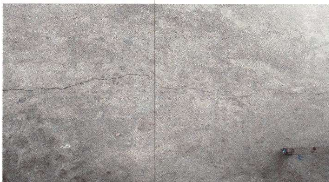
Foto 4: Sustrucción de piso cerámico
