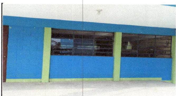
Foto 6: Fabricación e instalación de balcones de metal
